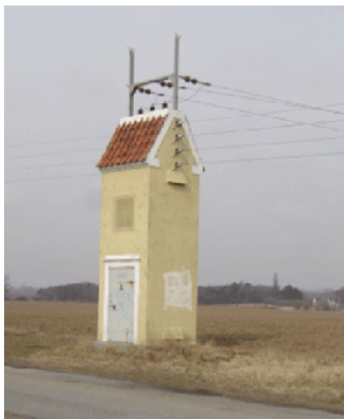
Foto 3: Muret transformatorstation fra omkring 1920'erne i funktion - syd for Råbylille Tokker.
