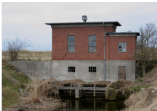
Foto 8: Pumpestation ved Gammelsø Mose
