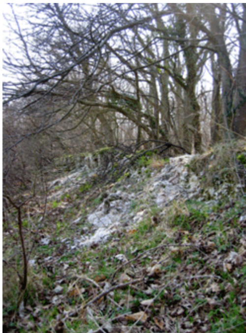
Foto 5: Tangdige på nordsiden af Ulvshale
