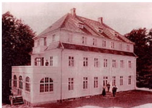
Foto 7: Hotel Storeklint blev opført i 1910. Det har bevaret sit udseende helt
