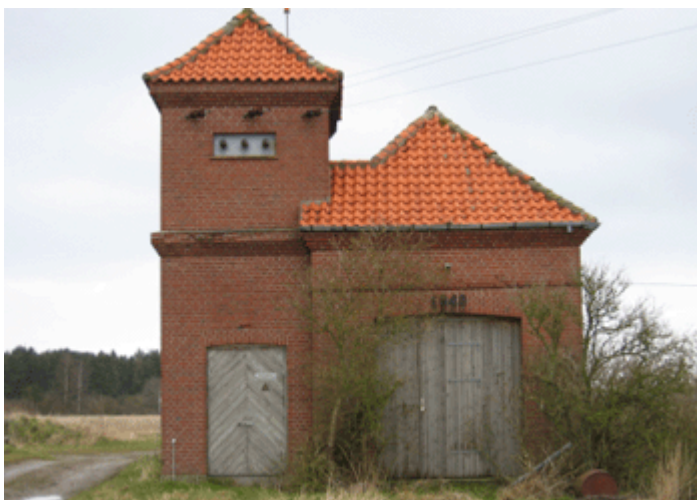
Foto 5: Pumpestationen i Borre Sømoses nordvestlige hjørne.
