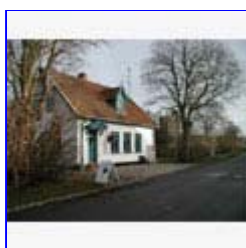
Huse på blød grund: Posthuset på Nyborrevej
