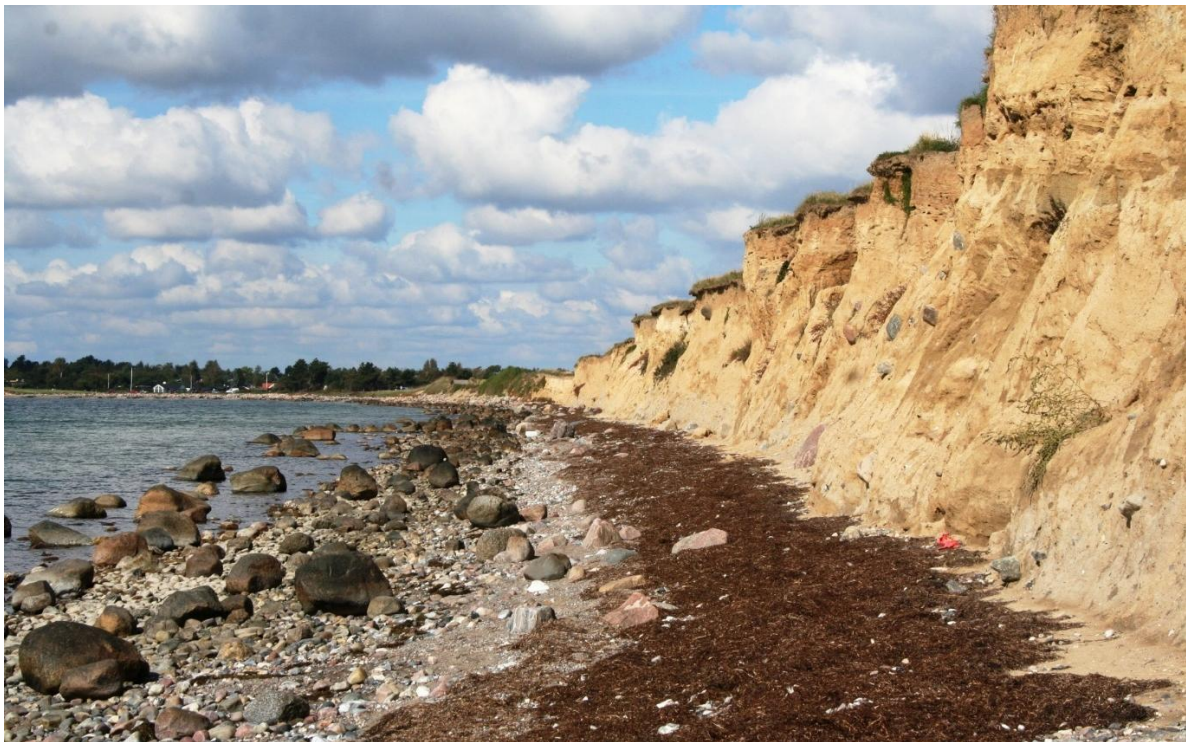
Figur 4-8. Kystklint ved Enø som er udsat for erosion. Foto: Næstved Kommune.
